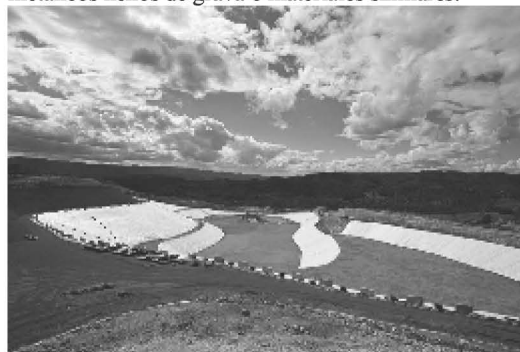
Figura 17. Vertedero controlado en el que una capa de dos metros de aislantes, separa los residuos del suelo.
