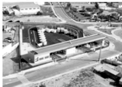
Figura 10. Planta de transferencia.
