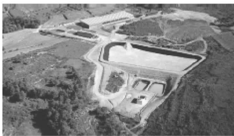
Figura 11. Planta de compostaje. Espluga de Francolí (Tarragona).
