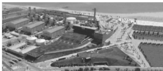
Figura 15. Planta Integral de Valorización de Residuos (PIVR) de Sant Adrià de Besòs; se trata de una instalación de tratamiento integral de los residuos municipales del área Metropolitana de Barcelona.
